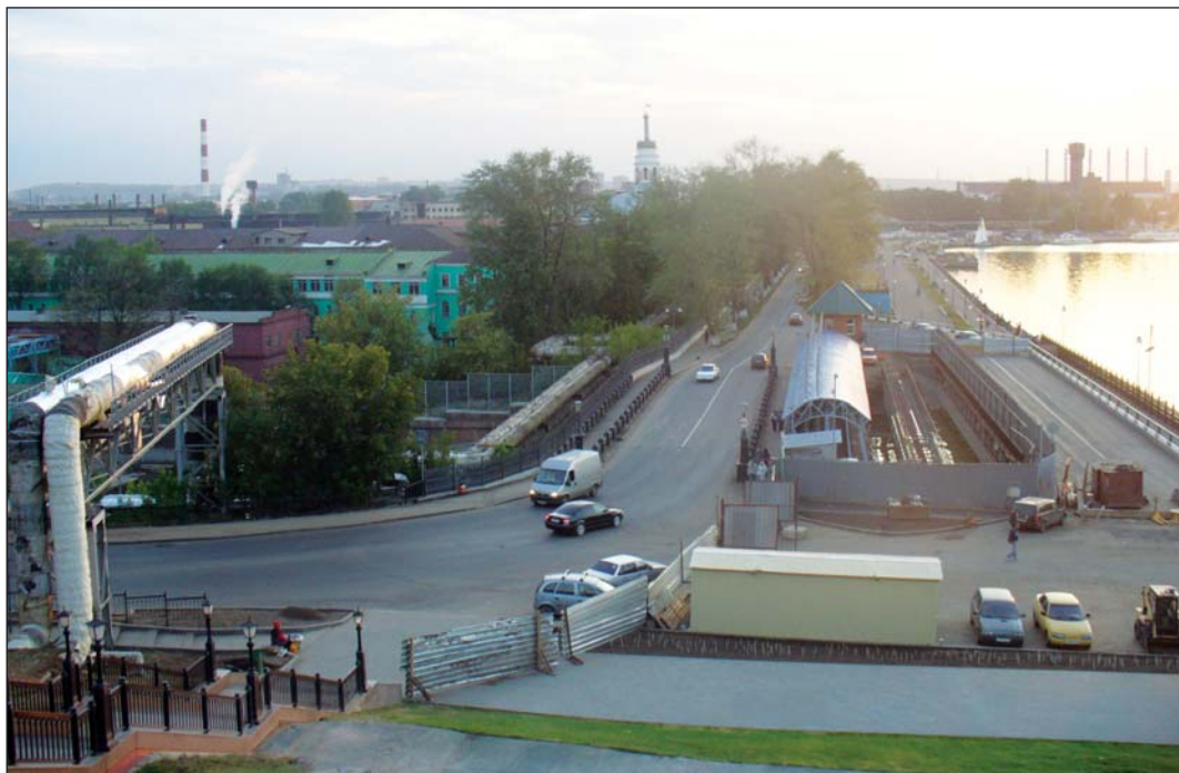
Мост на заводской плотине
